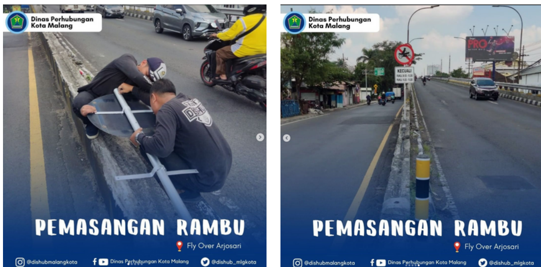
Gambar 3. Dokumentasi Pemasangan Rambu Lalu Lintas Fly Over Arjosari
